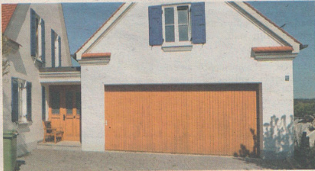
Ein Garagenbau kann für Überraschungen sorgen.
